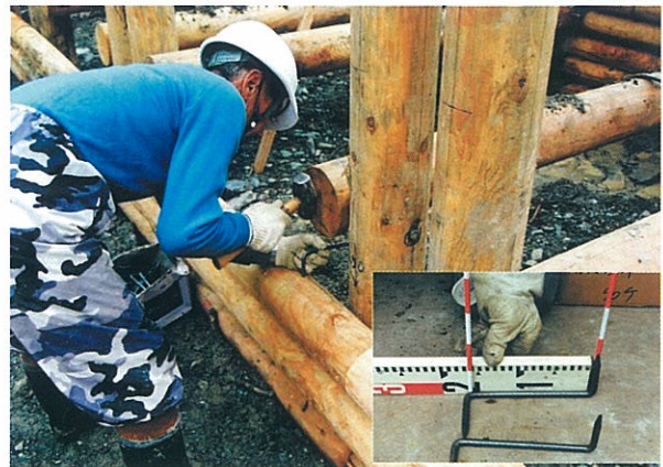
「手違いカスガイ」打ち込み
