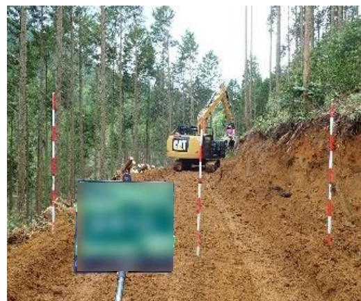
フェラーバンチャ付きグラップルバケットによる路網作設で作業効率と安全性の向上
