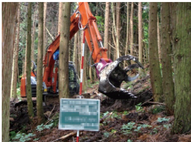
フェラーバンチャ付きグラップルバケットによる支障木伐倒
