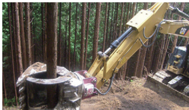
フェラーバンチャ付きグラップルバケットによる森林作業道作設
