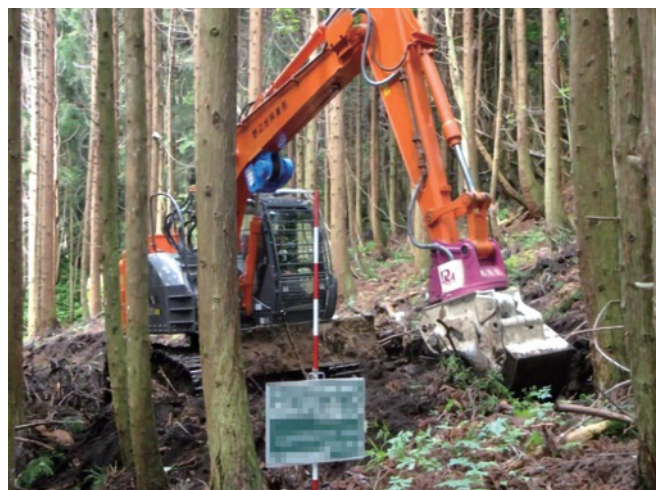
フェラーバンチャ付きグラップルバケットによる森林作業道作設
