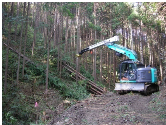
ロングリーチグラップルによる集材作業
