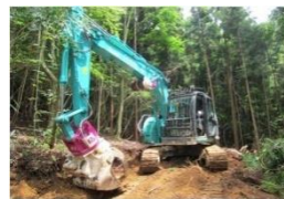
フェラーバンチャー付きグラップルバケットを活用した森林作業道の作設
