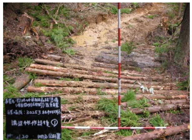
簡易で壊れにくい路網(軟弱路盤補強工)
