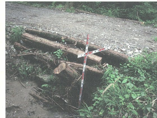
低質材を活用し、暗渠排水管を補強。
