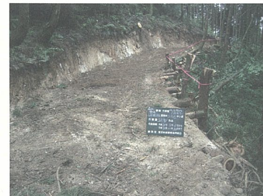
丸太組工により、切取法高を抑制。
