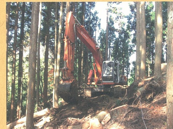
(作業路の開設)
