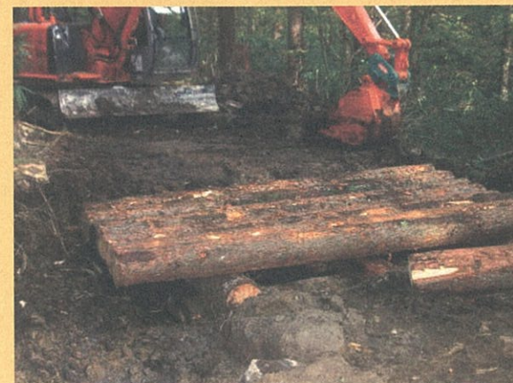
(丸太による路面工)
