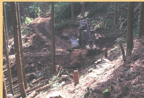
作業路開設の状況
