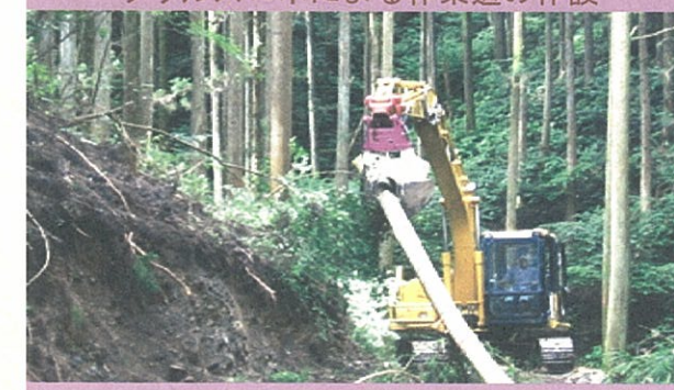
支障木を集材しながら作業道を作設
