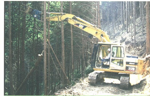
伐倒はチェーンソーで行い、低コスト作業路を活用しスイングヤードで集材します。
