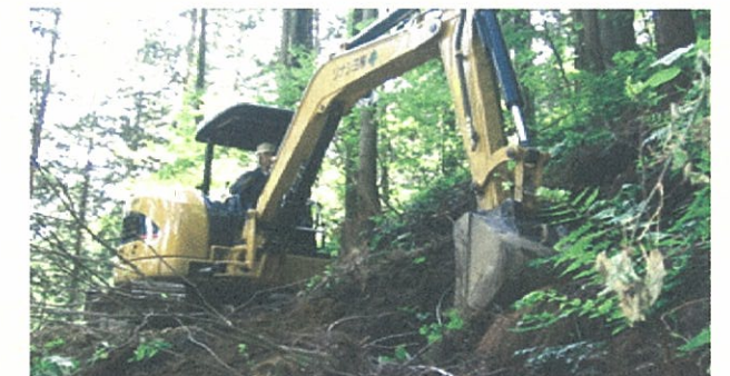
急傾斜地に小型機械で支線を作設
