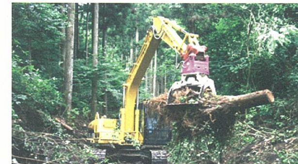
ザウルスロボによる作業道の作設
