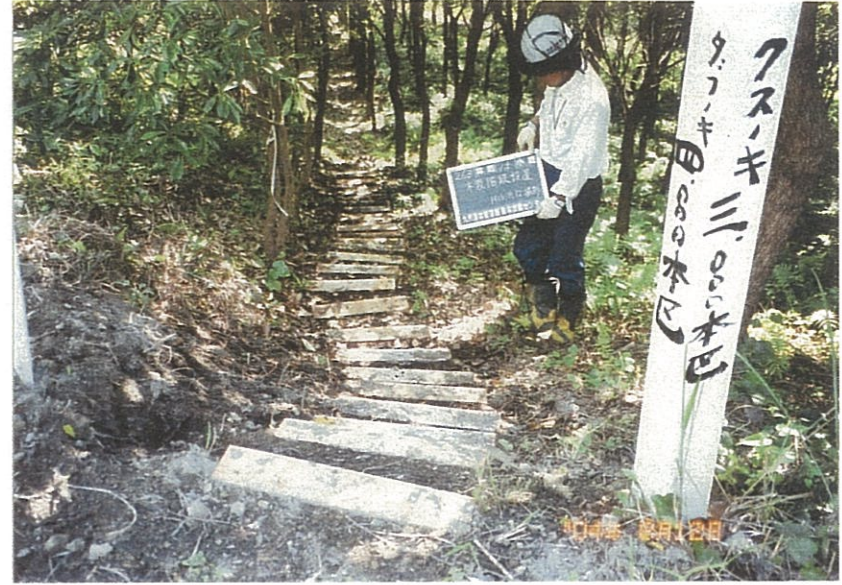
写真2 木製階段設置
