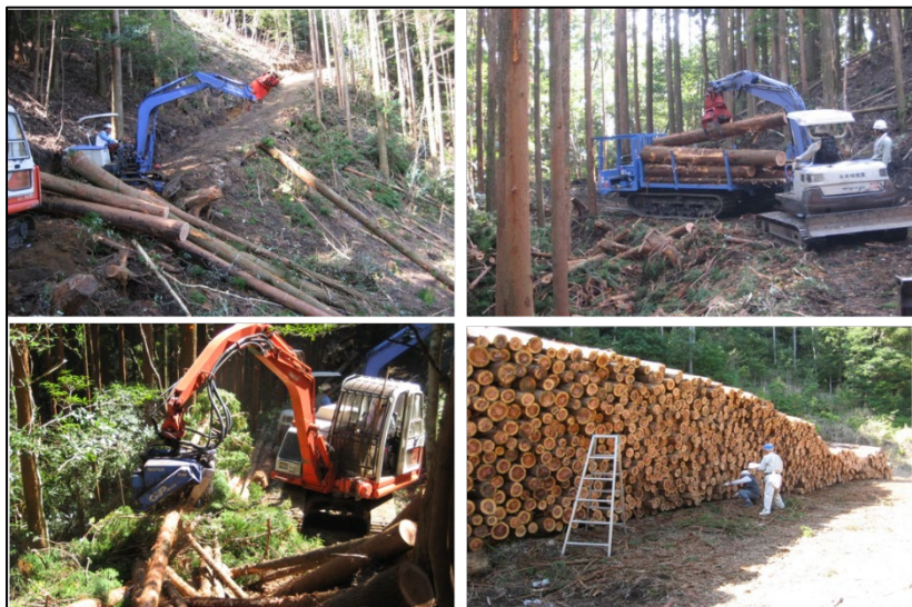
写真 1 車両系システムによる作業
