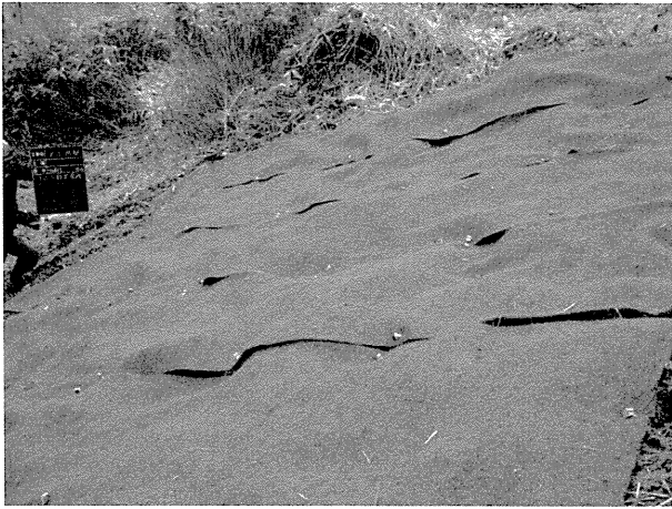
写真9 ヤシマットを敷いた状態
