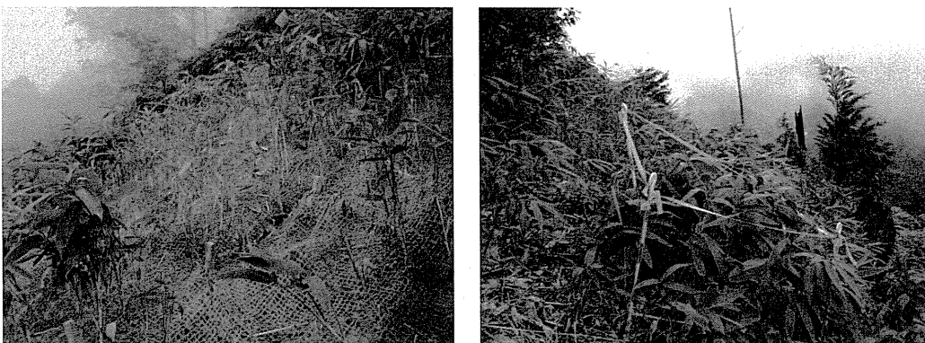
写真5 設置3ヵ月後の刈払いのみのプロット 左は植生マット設置箇所、右は対照区
