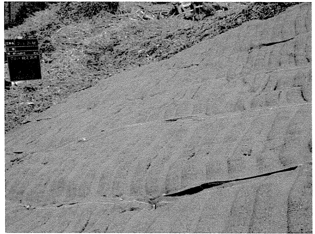
写真10 基盤材のついたマットを敷いた状態
