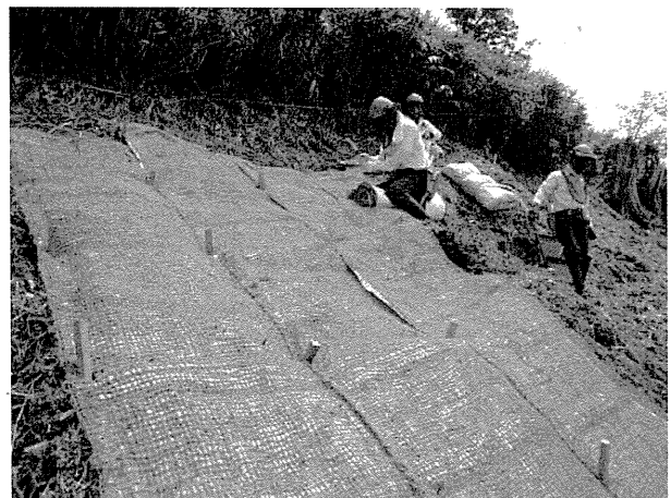
写真4 植生マットを設置した様子
