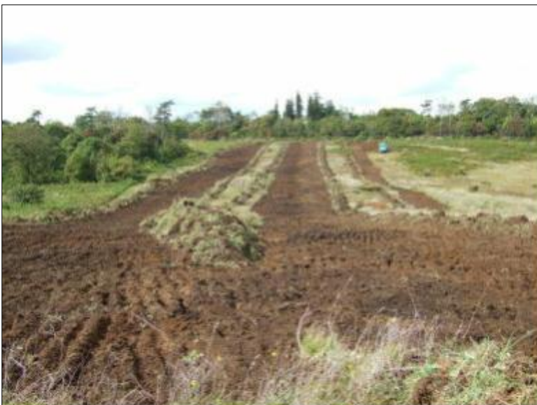
写真 2 建設用バックホウ による牧草剥離後の状況 列状に牧草を剥離。写真左 と奥が母樹林
