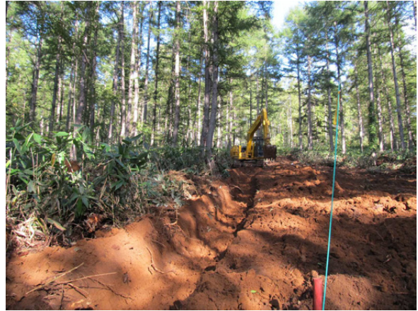
図-10 C試験区の作業状況
