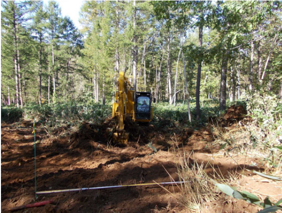
図-9 A試験区の作業状況
