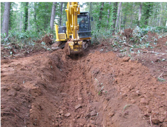
図-11 土砂流出防止側溝の作業状況（E試験区）
