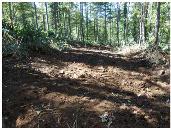
図-12 造成完了したH試験区
