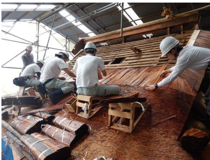
写真-15 屋根に檜皮を葺く様子
