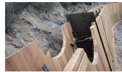
(写真2：水路部欠こみ処理)
