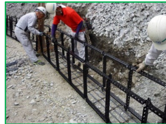
写真7 連結した残存型枠の骨組み
