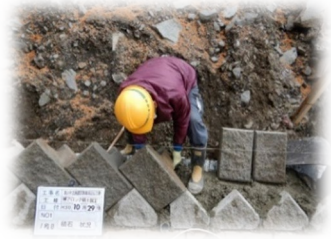
写真2 間知ブロック
