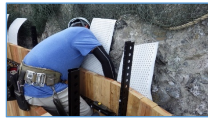
写真 20 板状排水材の取付
