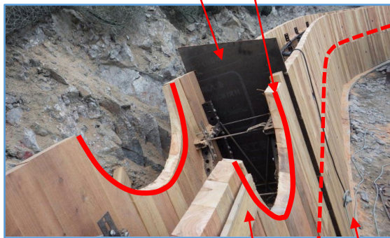
写真 18 木製残存型枠の設置状況
