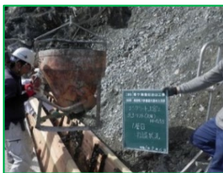
写真8 コンクリート打設
