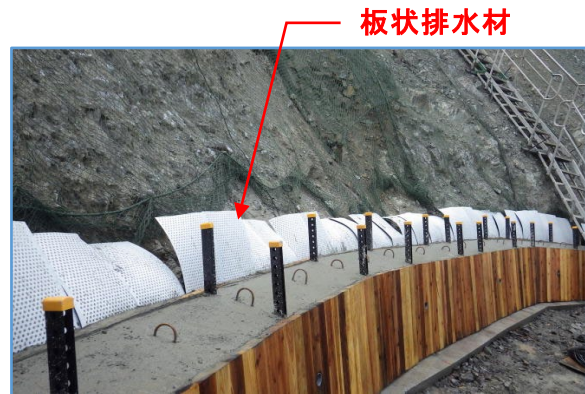
写真 17 1 段目のコンクリート打設完了
