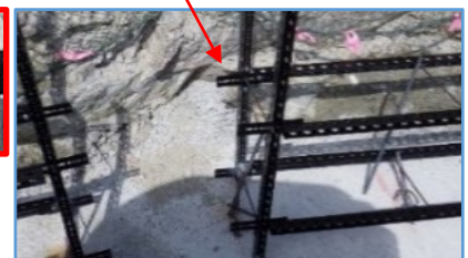
写真 15 十字プレート取付
