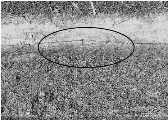
写真-4 動物の絡み、ネットの破れの確認
