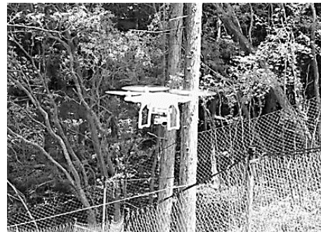
写真—1 ドローンによる防護柵点検
