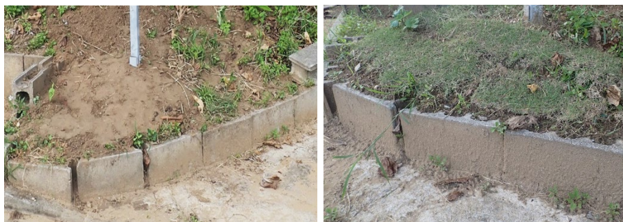
写真3 大原事務所の芝生設置箇所 左から設置前、設置後の様子
