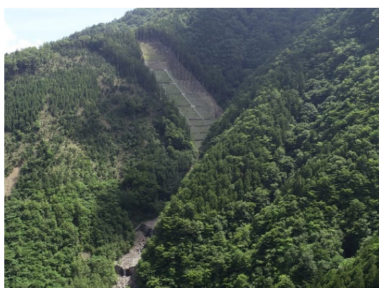
写真 16 現在の別府山 52 林班 （令和 2 年撮影）
