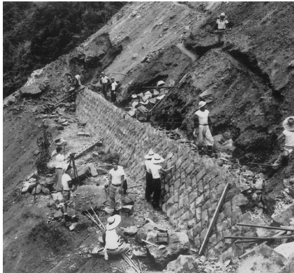
写真 10 練積工施工中
