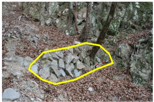
写真8 短い区間にも施工
