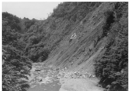
写真9 柿ノ火手の崩壊 (昭和30年撮影)
