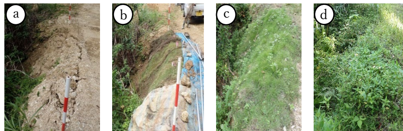
(写真2：国有林内の法面崩壊地に移植した芝生。)
