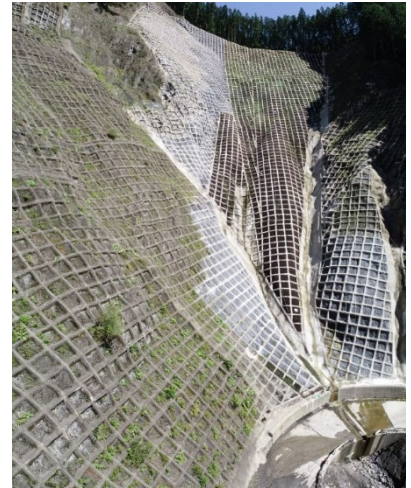
（写真—1）治山工事現場
