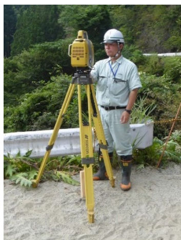
(写真—5) TLS 観測の様子
