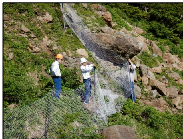
図2 植生保護柵設置作業の様子
