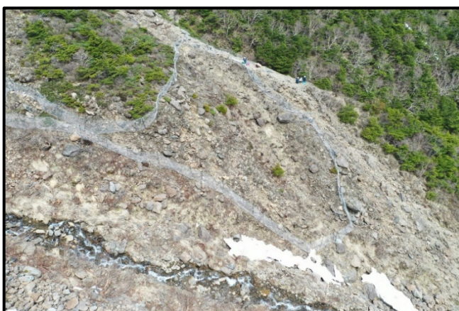
図5 植生保護柵設置箇所 (標高: 約1,390m 延長: 150m)
