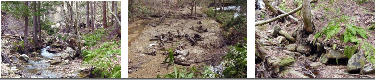
写真－５ 危険木等（溪流沿いの植栽木・堆積木・根が露出した傾倒木
