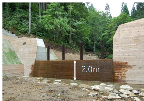
写真-2 鋼製スリットダム工
