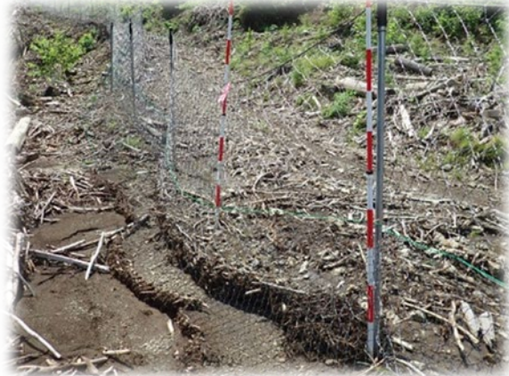
(写真-2) ネットが角に絡まり暴れる雄シカ (写真-3) 堆積土砂がネットを緊張する様子
