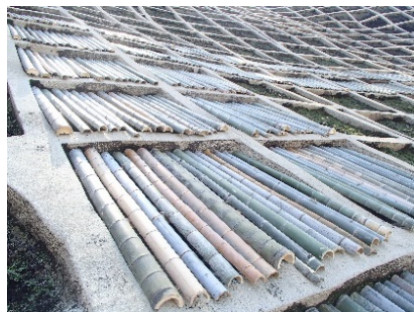
(写真1：竹被覆工施工地)
