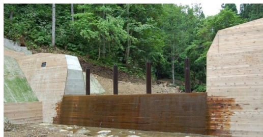
写真1 流木捕捉式治山ダムの完成状況
