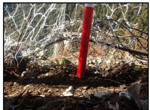
写真 6 防護柵と地面との隙間
