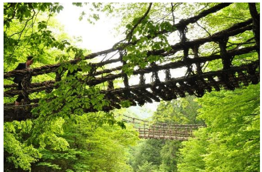
写真2 奥祖谷二重かずら橋 手前が女橋・奥が男橋
