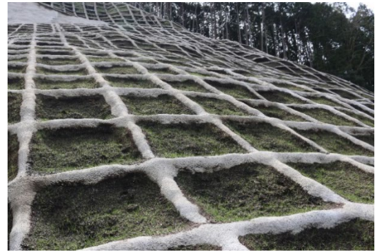
写真-4 簡易法枠工
