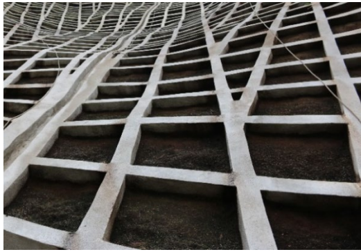
写真-3 法枠工
