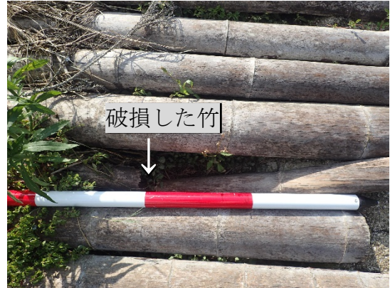
写真-12 竹の破損状況（令和2年8月撮影）
