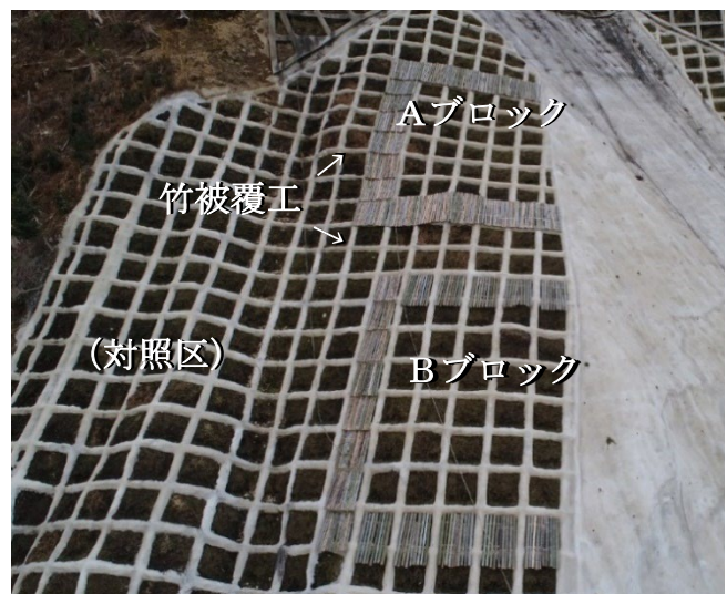
写真-5 高津工区試験地の全景 (平成 31 年 1 月施工)
