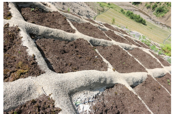
写真-14 Bブロックの様子（令和2年8月撮影）
