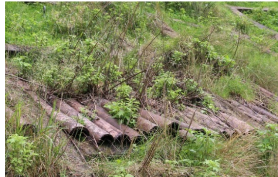
写真-8 竹被覆工に草が繁茂した様子（令和元年7月撮影）
