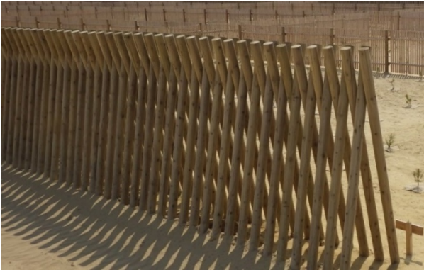
写真-2. 丸太防風柵工
