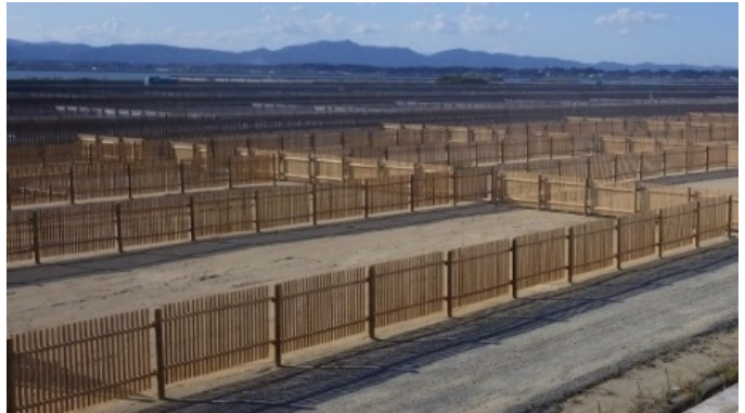
写真-3. 静砂垣工
