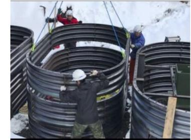
写真 2：型枠（ライナープレート）の据付
