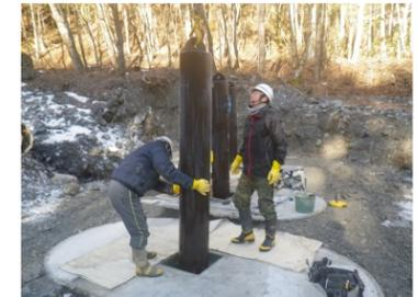
写真 4：鋼製スリットの設置
