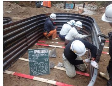
写真 1：型枠（ライナープレート）の組立
