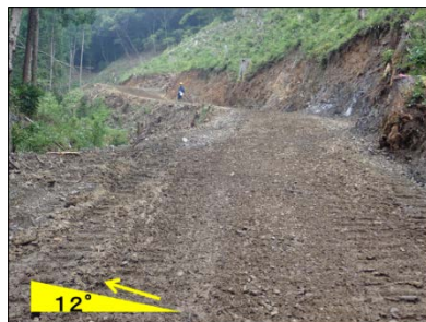
写真1：勾配12°の作業道
