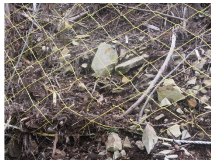
写真-3 ウサギによる噛切被害
