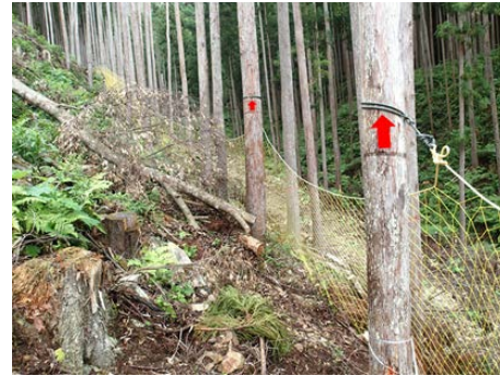
写真-10 修繕後の状況
