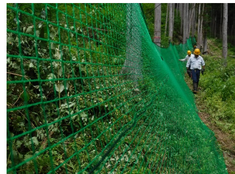
写真-8 新たな斜め張り施工完成状況
