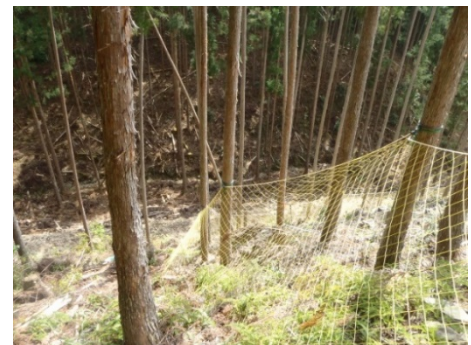
写真-1 斜め張り施工完成状況
