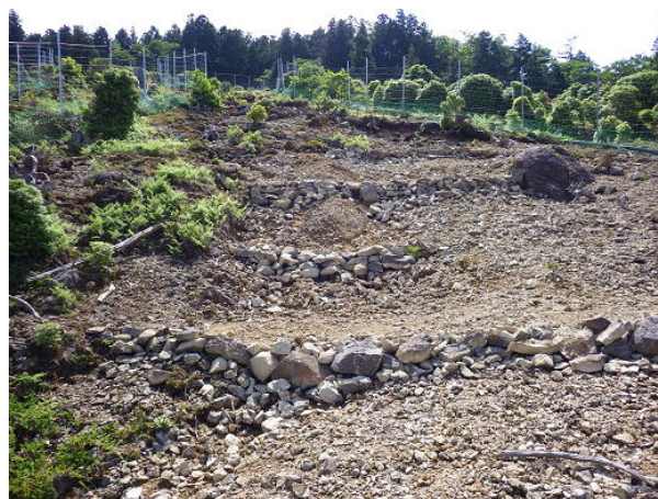
写真 2 現地転石を活用した空石積工
