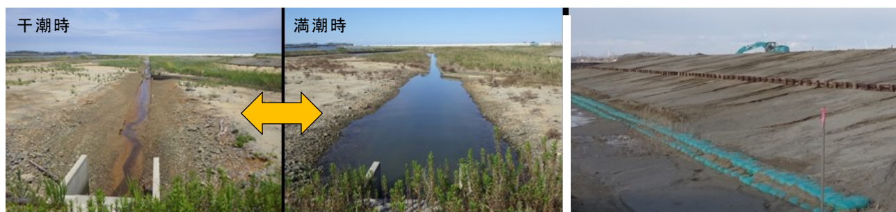
(写真-2) 汽水を流入させるために新設した水路 (①)
