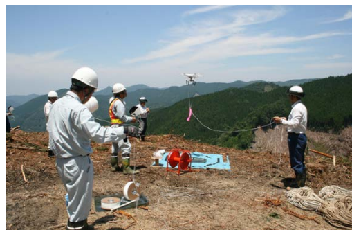
図-4 UAVによる索張り実証実験
