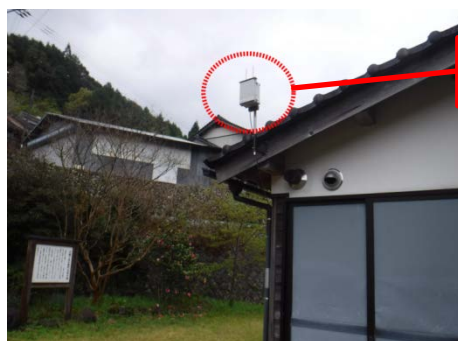
写真8：親機設置状況
