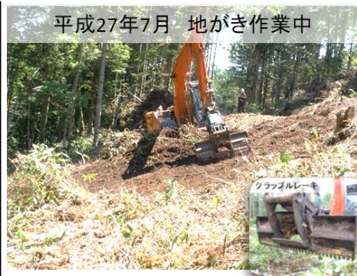
写真1 グラップルレーキによる地がき作業の様子
