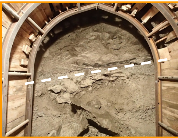
写真1. 破断面写真
