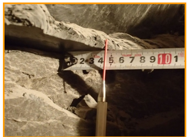
写真2. 破断面接写写真
