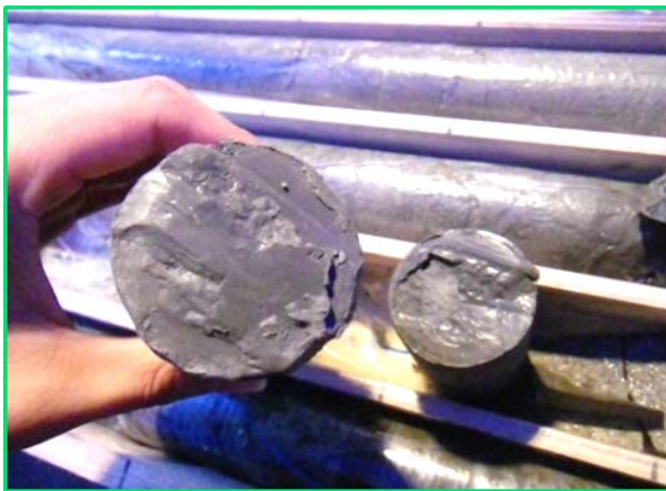
写真 3. 109m 集水井 すべり面の痕跡
