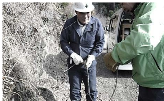
図5：現地での設置方法の講習
