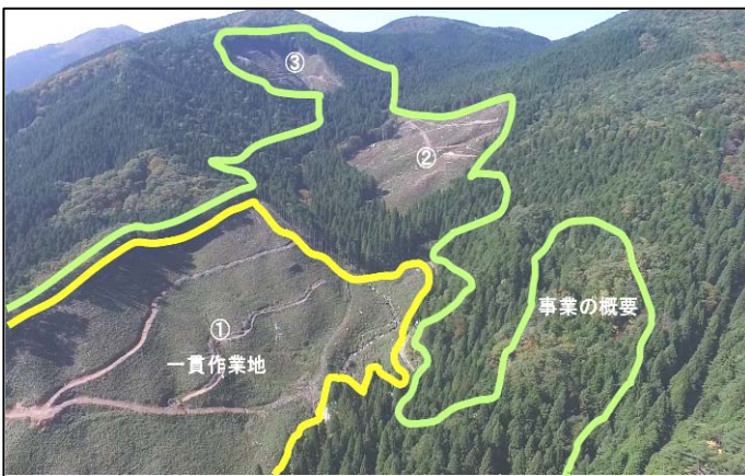
写真-1 伐採区域の様子
