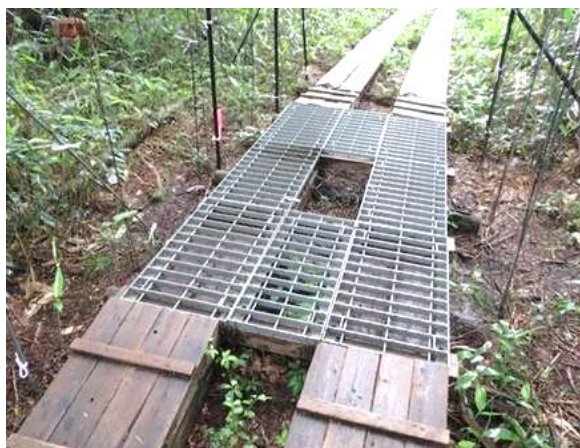
（写真－２） グレーチング設置状況
