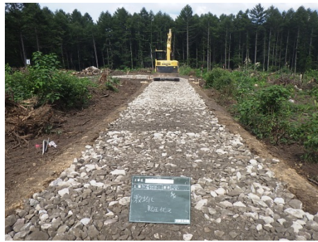
写真4 割栗石充填状況
