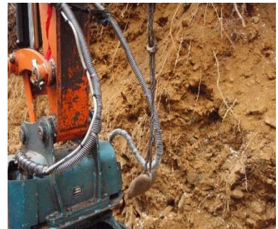
写真-8 荷掛索はワイヤー用
