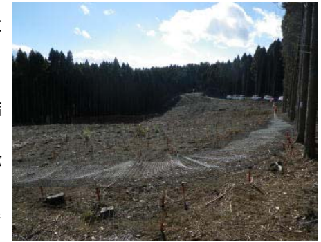
写真-2 宙かせ張り全景
