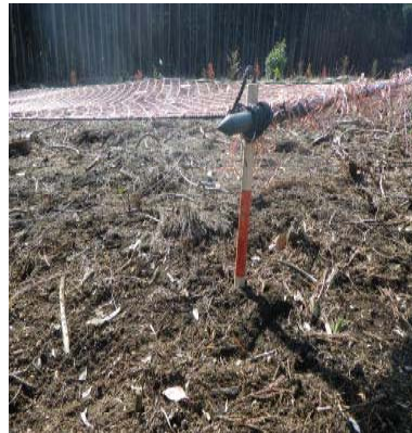
写真-1 支柱の設置状況
