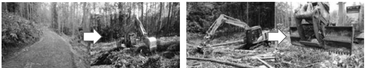
写真1 作業道作設等に用いたバケット（左）と木寄等に用いたグラップル（右）による地拵
