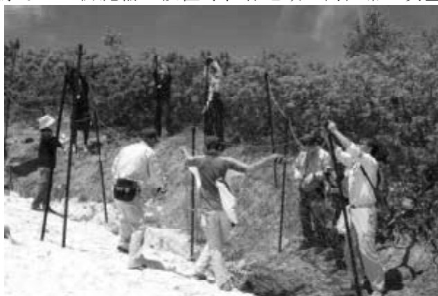
写真 2 仙丈ヶ岳での防鹿柵設置状況
