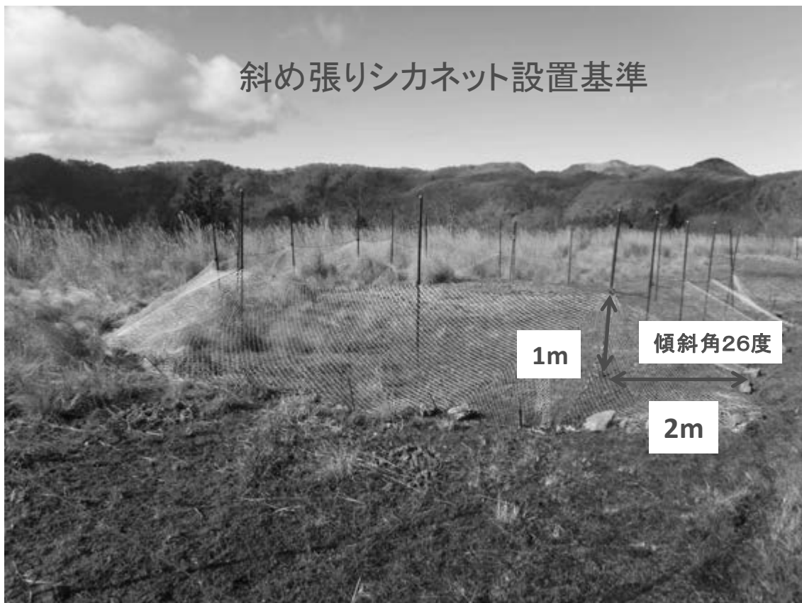
写真４ 軽量化した斜張式防護ネット
