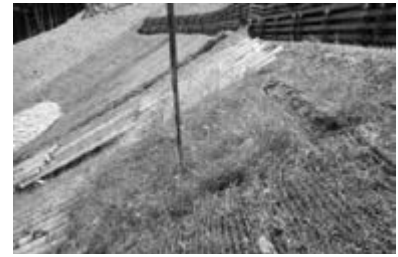
写真-8 伏工内の生育状況
