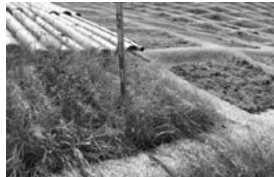
写真-7 簡易法枠工内の生育状況
