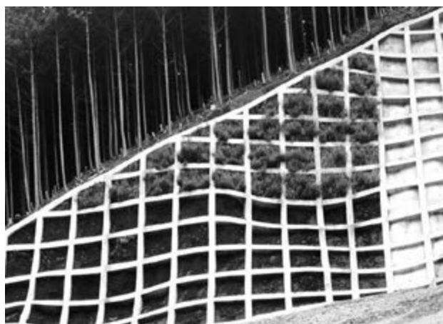
写真-1 平成 26 年度施工法枠工 (平成 27 年 6 月)
