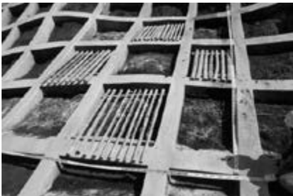
写真-3 法枠工内の設置状況
