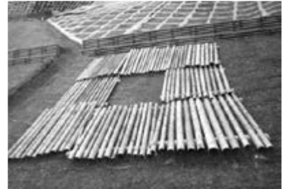
写真-5 伏工内の設置状況
